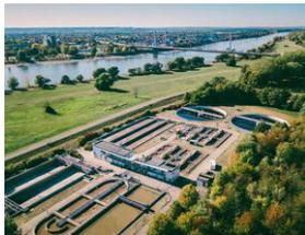
3.000 Liter Abwasser in der Sekunde durchfließen die Anlage. Zunächst filtert ein Rechen die Grobteile heraus, dann erfolgt die Feinsäuberung durch einen Sandfang und anschließend setzt der Prozess der Bakterien ein, bevor das geklärte Wasser in den Rhein gelassen wird. Der Klärschlamm wird übrigens durch eine Rohrleitung in das Klärwerk in Graurheindorf auf der anderen Rheinseite gepumpt.
