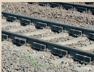
Schall-Absorber in der Südstadt
